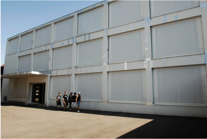
Mit Klebefolien abgedeckt: Das Schulhaus 2001. ZA
