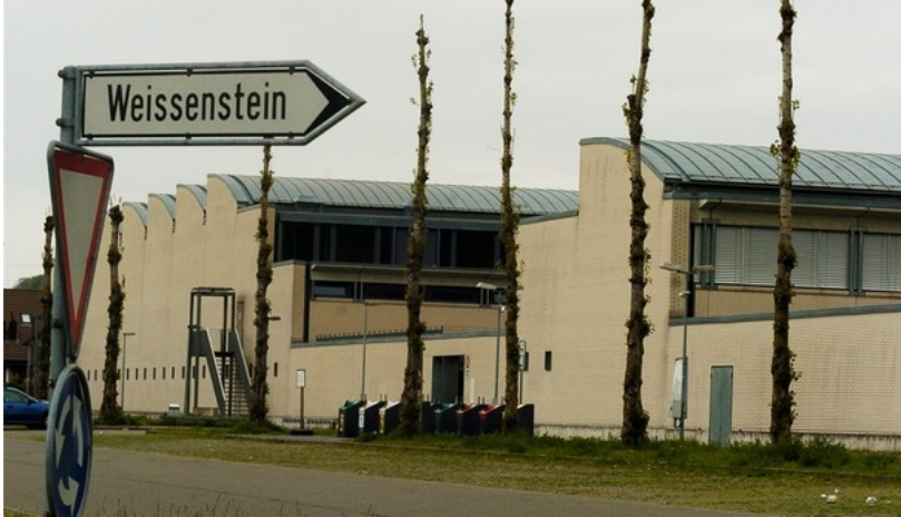
Priorität beim Ausbau hat die Schulanlage Weissenstein. Quelle: Angelo Zambelli
